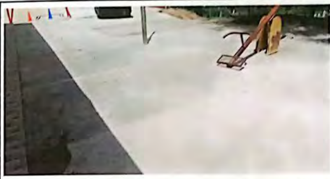
Foto 4: Reparación de piso de concreto
