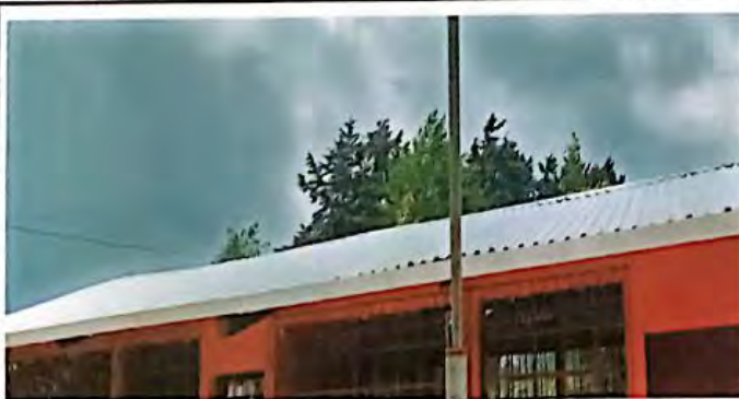
Foto 5: sustitución de lámina
