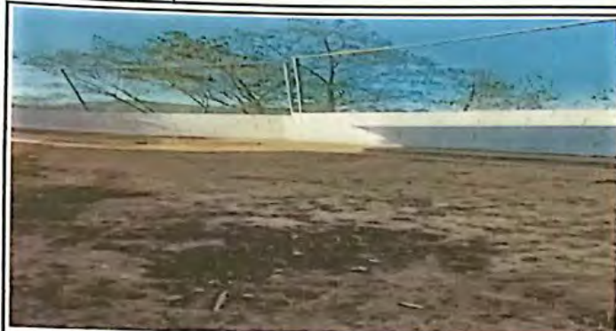
Foto1: Termination de media pared para uso de bodega
