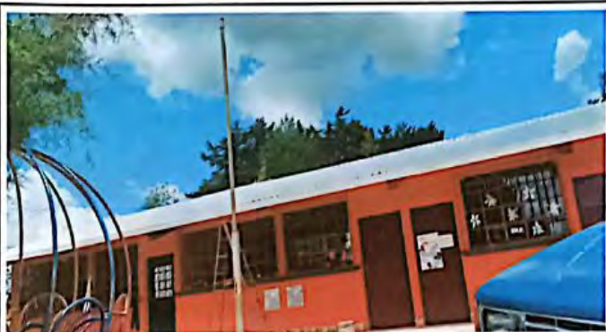
Foto 3: sustitución de lámina
