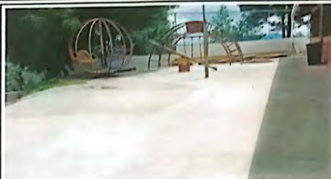
Foto 2: Mantenimiento de piso de concreto
