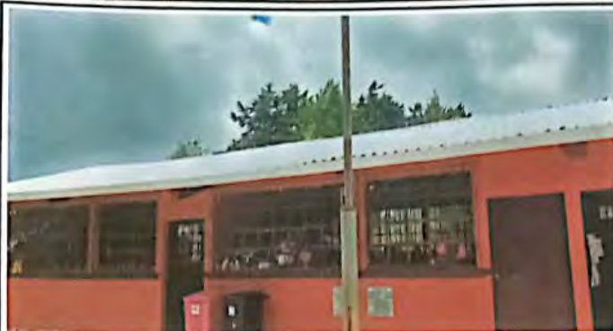
Foto 1: sustitución de lámina
