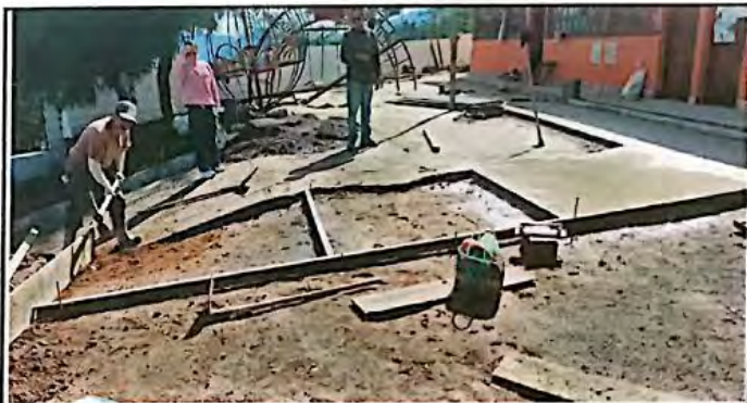
Foto 4: Reparación de piso de concreto
