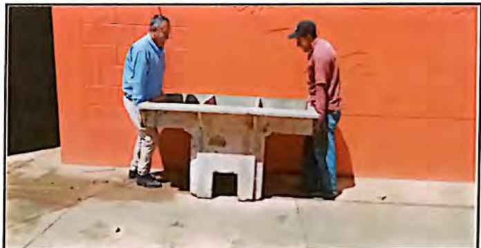
Foto 6: Sustitución de pila de dos lavaderos
