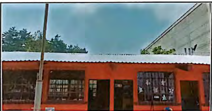
Foto 5: Sustitución de lámina
