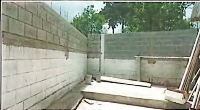
Foto1: terminacion de media pared para uso de bodega
