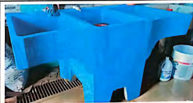
Foto 6: sustitución de pila de dos lavaderos
