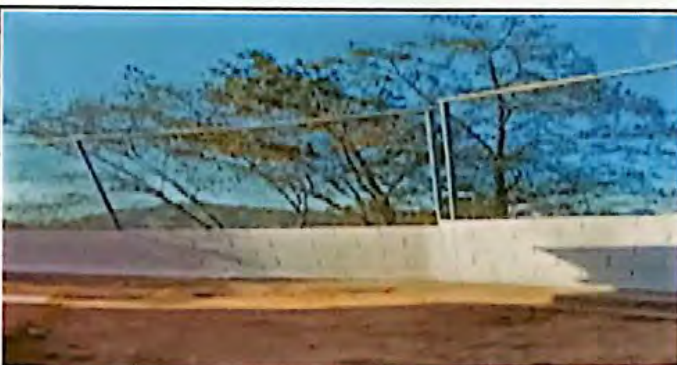
Foto 6: sustitucion de area de juego para bodega
