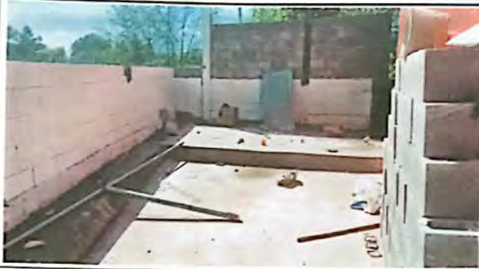
Foto 1: Terminación de media pared para uso de bodega
