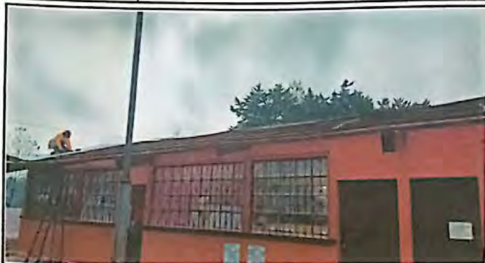
Foto1: Sustitución de lámina
