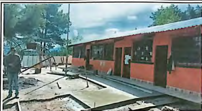
Foto 2: Mantenimiento de piso de concreto
