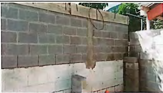
Foto 4: Terminar media pared para usar el espacio para bodega
