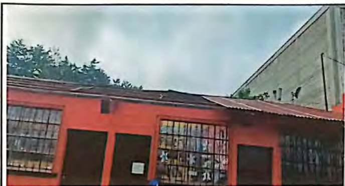
Foto 3: Sustitución de lámina
